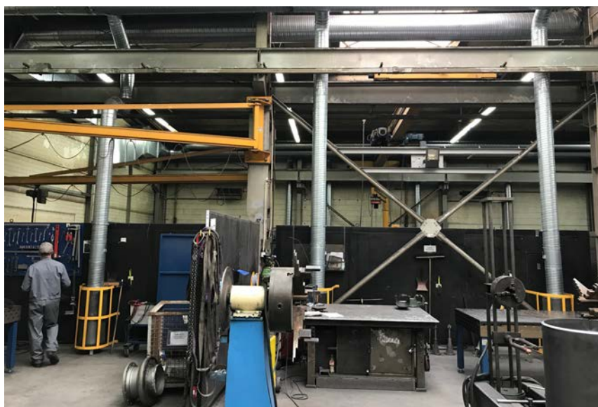
Rys. 4. Bezpośrednie wprowadzenie powietrza do kabin spawalniczych
